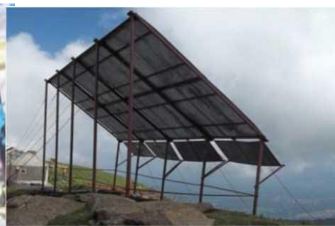
Fig. 6(d). Jet roofs avalanche prone area
